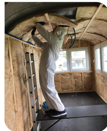
Umbau Bauwagen Projektmobil
